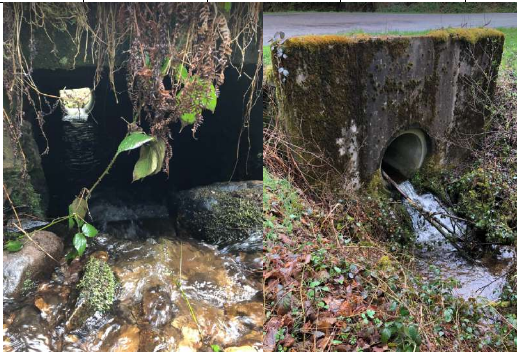
Vues de l'ouvrage amont (gauche) et aval (droite)
