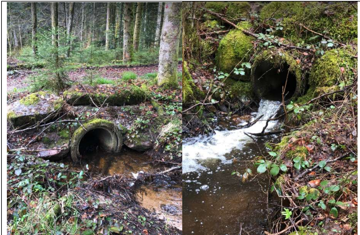
Vues de l'ouvrage amont (gauche) et aval (droite)
