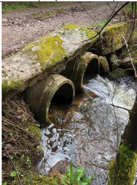
Vue aval de l'ouvrage
