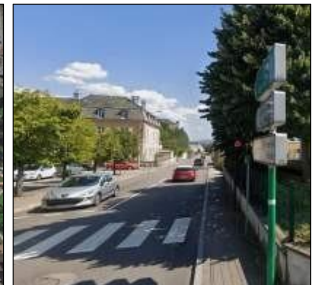
Des trottoirs non accessibles Rue Georges Lang
