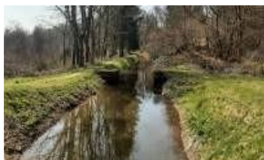
Canal d'alimentation du Réservoir de Bouzey
