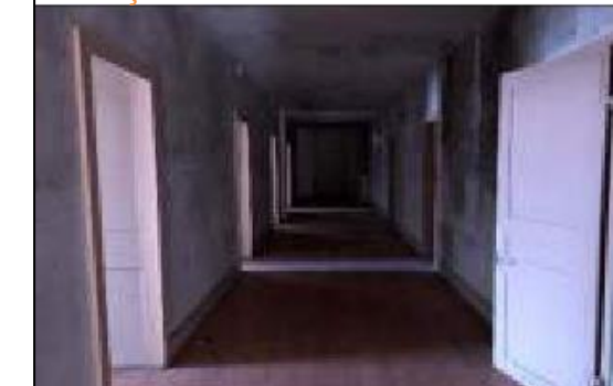
Des circulations généreuses
