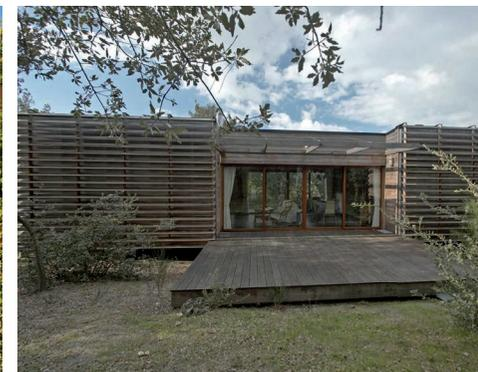
Construction surélevée : niveaux de plancher et de la terrasse adaptés à la cote des hautes eaux
